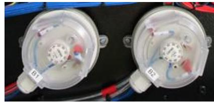
要修改设点时，打开压差开关的透明封盖，用平头螺丝起子转动压差开关内的电位器，顺时针方向为加大设定值，逆时针方向为减小设定值。
