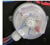
要修改设点时，打开压差开关的透明封盖，用平头螺丝起子转动压差开关内的电位器，顺时针方向为加大设定值，逆时针方向为减小设定值。
