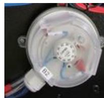
要修改设点时，打开压差开关的透明封盖，用平头螺丝起子转动压差开关内的电位器，顺时针方向为加大设定值，逆时针方向为减小设定值。
